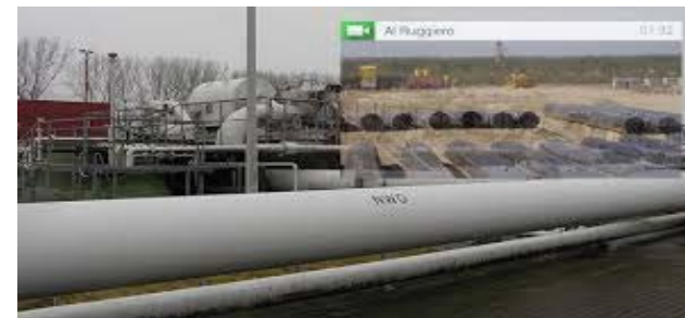
パイプライン検査
