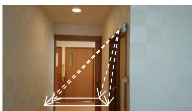
V50W型: センサーエリア内を通過すると通報 ※破線はセンサーエリアでイメージ図
